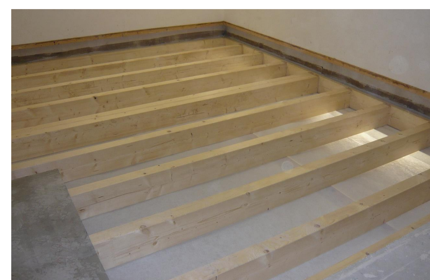
Holzbalkendecke im Raum 1
