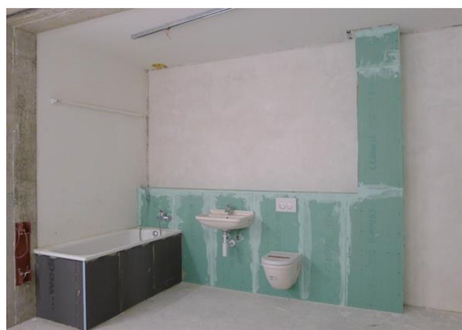
Messung der Luft- und Körperschallübertragung von Sanitärinstallationen
