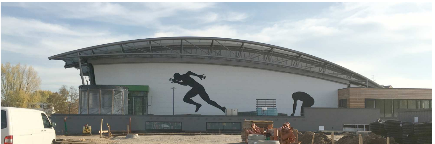
Bild 21: Seitliche Ansicht nach dem Einbau der oberen Membran
