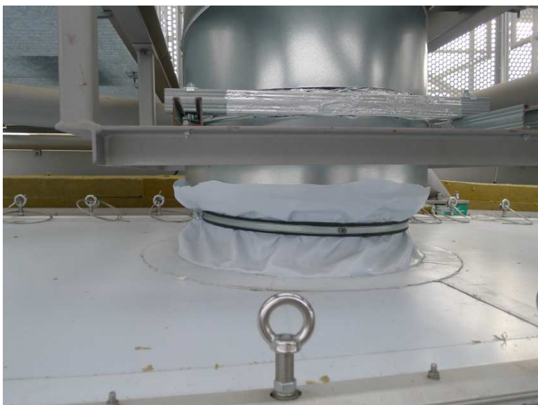
Bilder 37 und 38: Entrauchungsöffnungen. Links mit Anschluss an die innere Membran, die Wärmedämmung war zum Zeitpunkt der Aufnahme noch nicht eingebracht. Rechts vom Halleninnenraum aus gesehen
