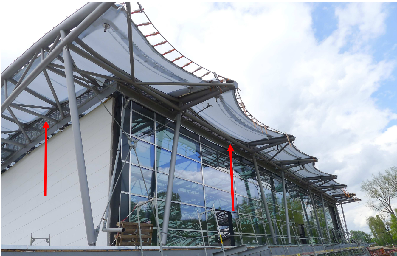
Bild 24: Ansicht vom Sportplatz aus nach Einbau der oberen Membran. An den Rändern des Daches sieht man das Lochblech (rote Pfeile)
