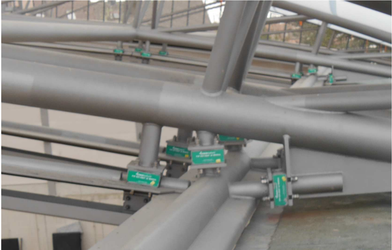
Bild 29: Anschluss der Stahlträgerstruktur an die rückwärtige Wand
