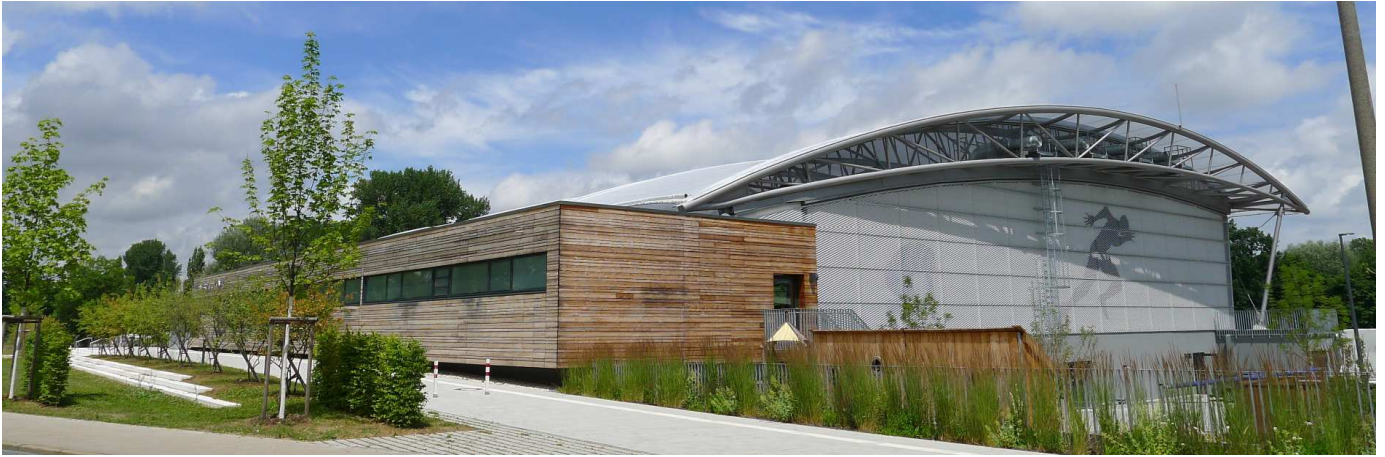
Bild 20: Ansicht von der Straßenseite
