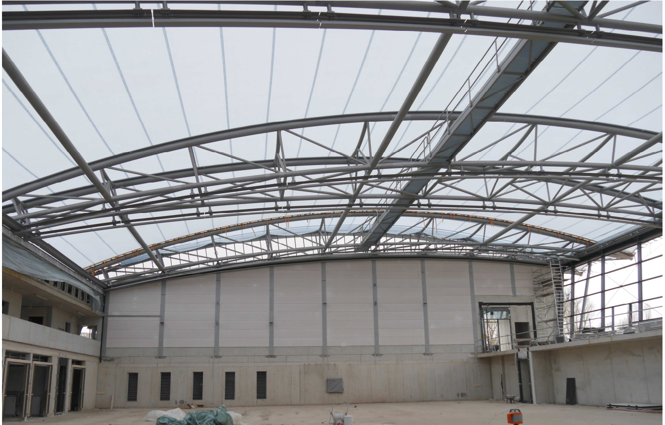
Bild 23: Ansicht des Halleninnenraumes mit der Stahlträgerstruktur und der äußeren Membran. Der innere Dachaufbau fehlte zum Zeitpunkt der Aufnahme noch.
