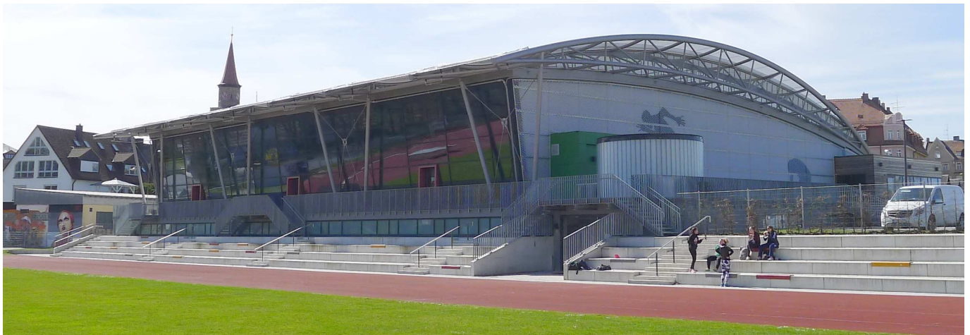
Bild 1: Außenansicht der Sporthalle nach der Fertigstellung
