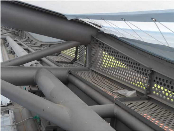
Bild 36: Lochblech-Abschluss am Nord-Ost-Rand des Membrandaches
