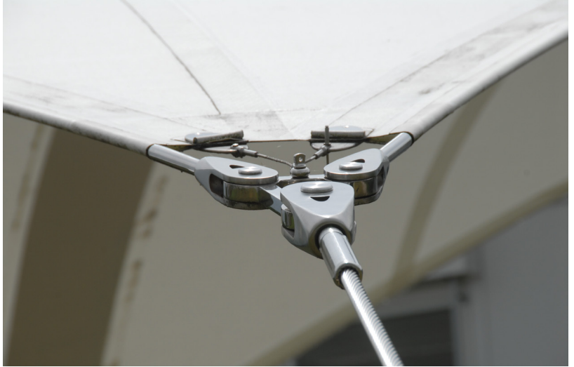
Abbildung C29: Weiteres Eckdetail; 4-Punkt-Segel-Rimsting
