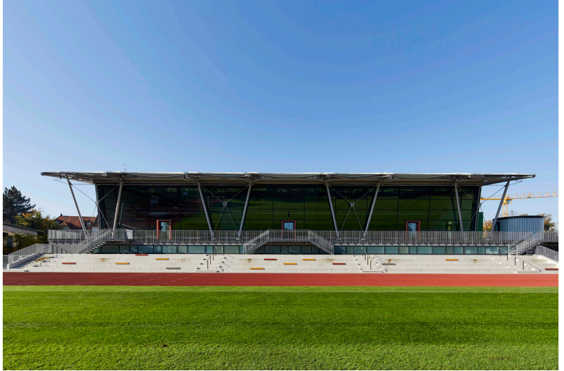
Abbildung B50: Sporthalle Fürth, Außenfassade vom Sportplatz
