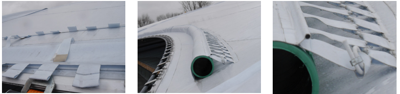
Abbildung C37: Beispiel Fürth: Membranwulst mit Drainage
