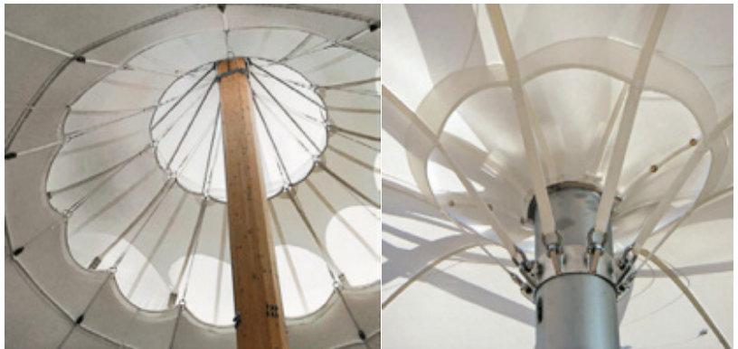
Abbildung C31: Beispiel für einen Hochpunkt mit Rosette rechts und einen Tiefpunkt mit Rosette
