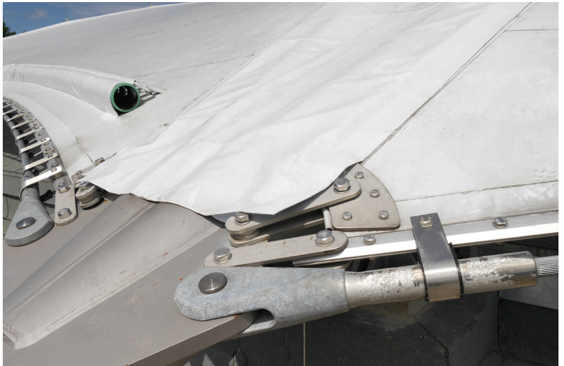
Abbildung C30: Sporthalle Fürth Eckausbildung mit Überlappungsmembran
