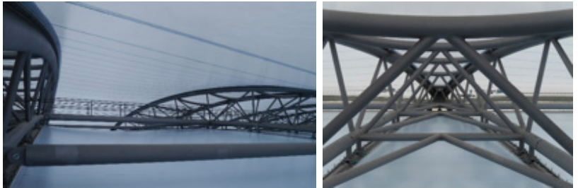
Abbildung C7: Fachwerkträger mit V-Verstrebung im Dachzwischenraum
