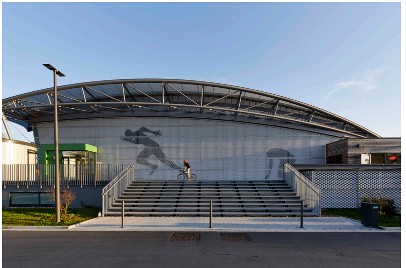
Abbildung B51: Sporthalle Fürth, Außenfassade mit Membrandach
