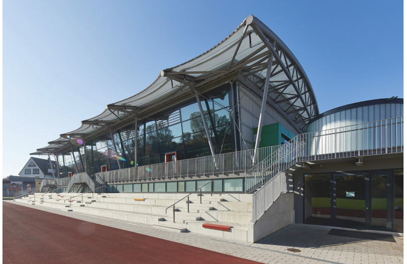
Abbildung B43: Sporthalle Fürth, Außentribüne
