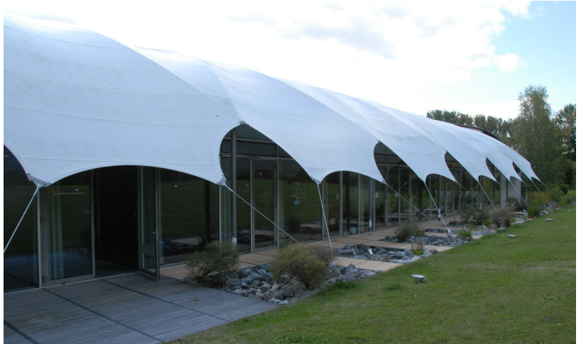
Abbildung C2: Kulturzentrums Puchheim, seitliche Abspannungen
