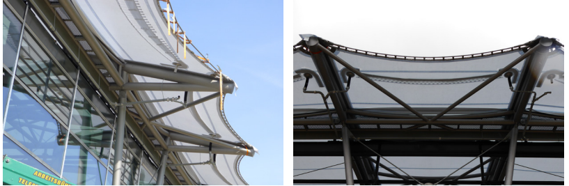
Abbildung C36: Beispiel Fürth: Seilrand mit Schneefang und Drainagerohr
