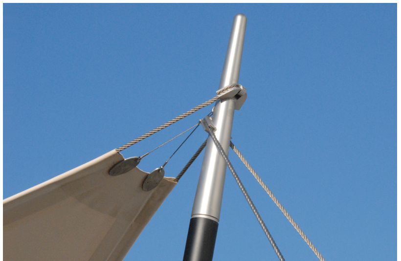
Abbildung C28: Eckdetail; 4-Punkt-Segel-Rimsting
