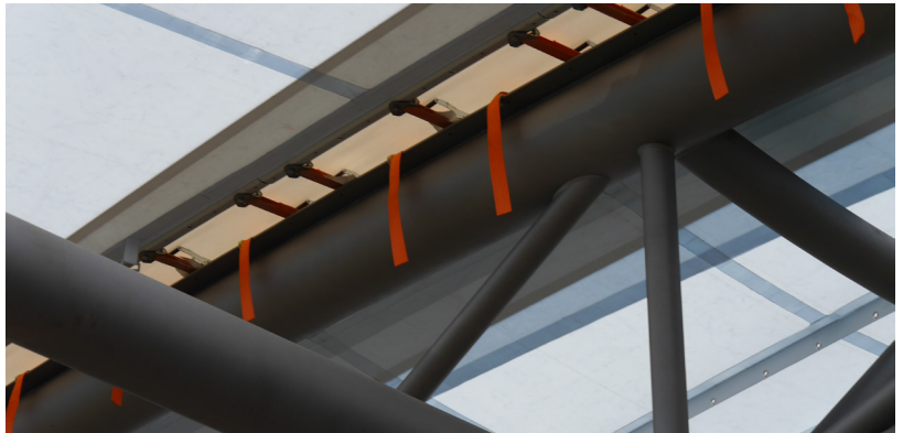
Abbildung C44: Sporthalle Fürth Spannung der Membran mit Gurten und provisorischer Überdeckklappen
