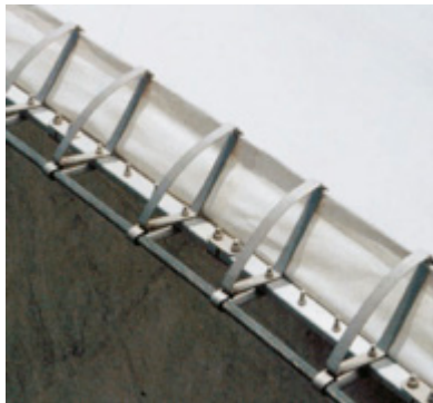
Abbildung C32: Aufgekanteter Membranrand mittels Profileteilen
