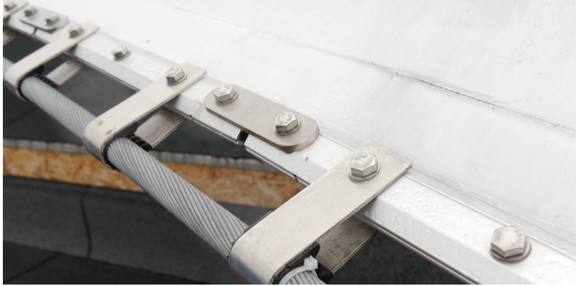
Abbildung C26: Sporthalle Fürth, biegeweicher Randabschluss
