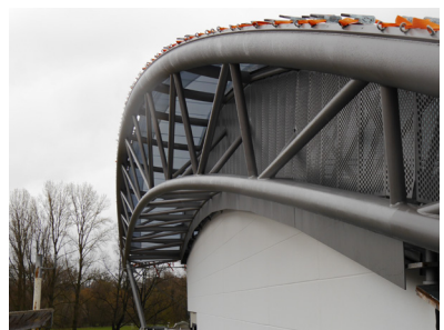
Abbildung C39: Abschluss des Zwischenraums der Membrankonstruktion in Fürth mit Lochblech (50% Öffnungsanteil), innen. und außenseitig
