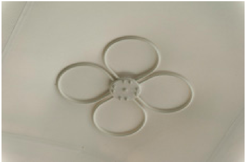
Abbildung B25: Aufnahme des Befestigungspunkt mittels sog. „Kleeblättern“
