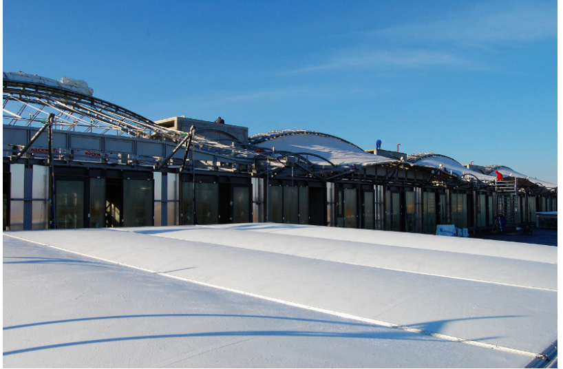
Abbildung B4: Membrankissen des 1-geschossigen Gebäudeteils (Technikum)
