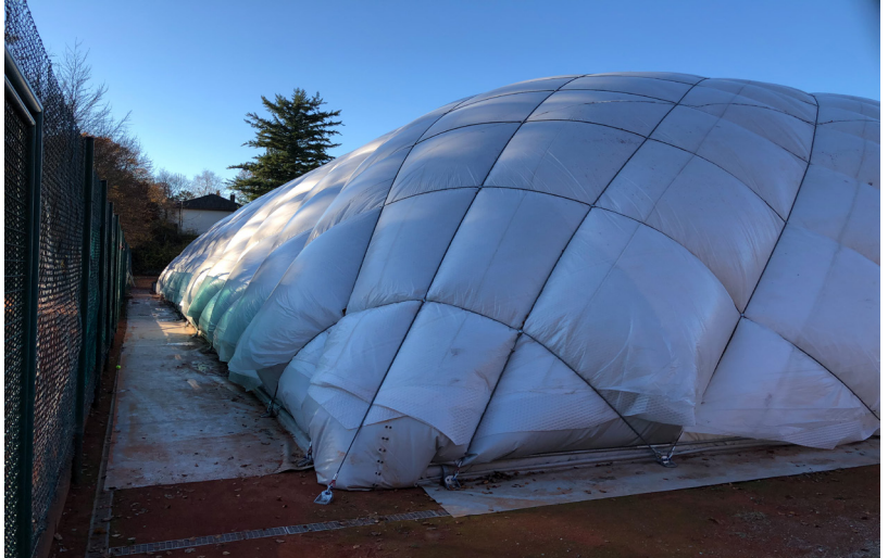
Abbildung C11: Traglufthallenkonstruktion (München)
