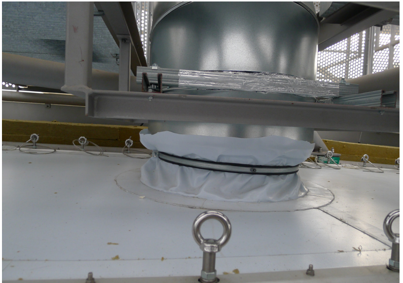
Abbildung C41: Sporthalle Fürth Detailbild Anschluss um die Entrauchungsrohre
