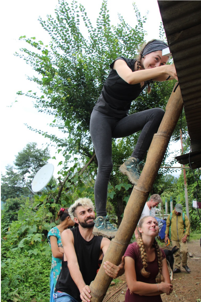
Installation des Solarpanels mit einer Bambusleiter
