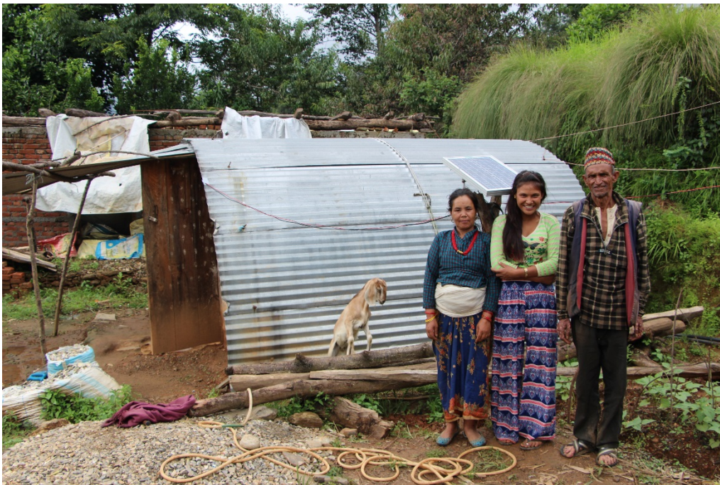
Die Bewohner mit einer neu installierten PV Inselanlage
