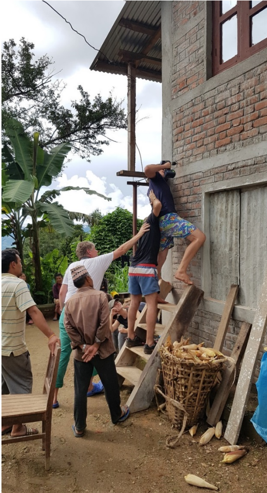
Fachgerechte Installation an einem Neubau
