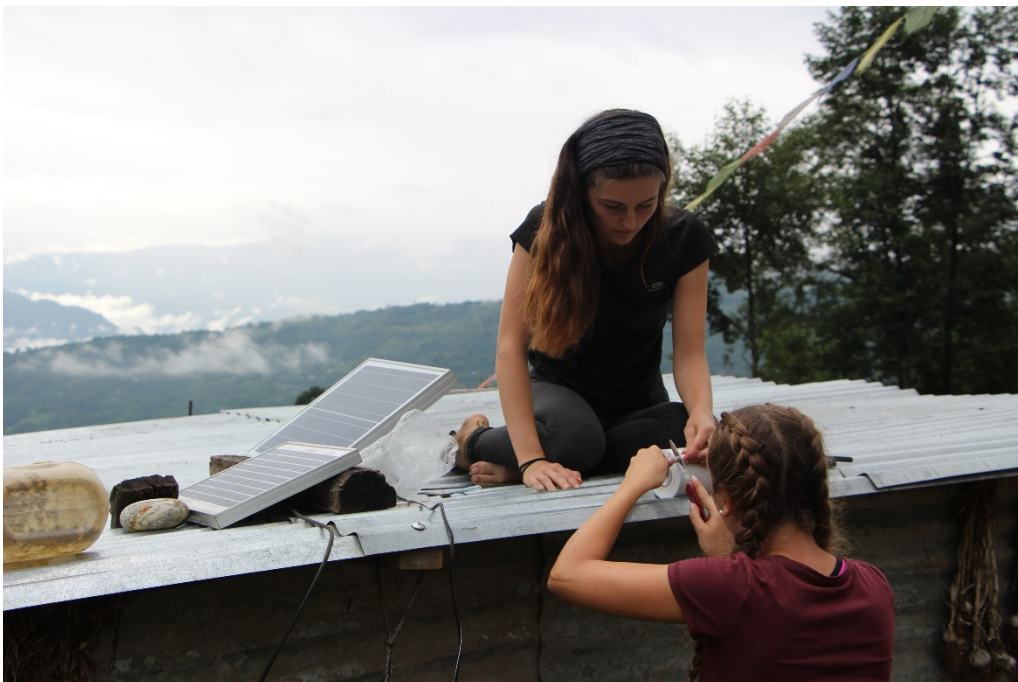
Installation der Panele
