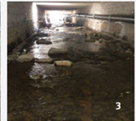
1 Bach zwischen Betonwänden 2 Eipbach in Ortslage 3 überbauter Bach mit Lichtschächten und offener Sohle
