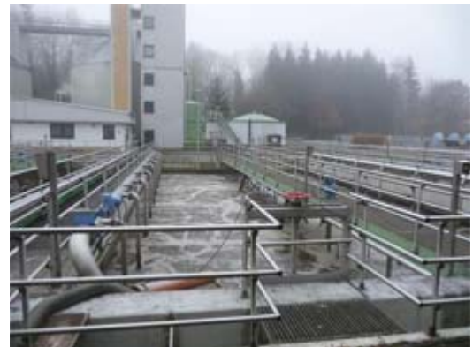
Biologische Stufe des Klärwerks Kressbronn-Langenargen
