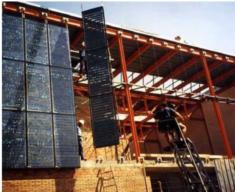
Abbildung 10: Elementkonstruktion einer 6.5m hinterlüfteten Photovoltaikfassade (Luftspalt 0.14m Bautiefe) als Regenerationslufferhitzer.
