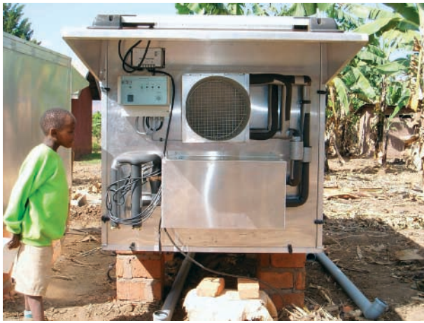
Abb. 5: Nachheizmodul des Solarvent 200 E Hybrid. Foto: HfT Stuttgart
