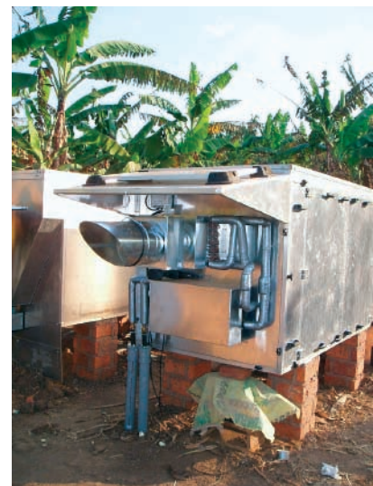
Abb. 4: Solarvent 200 E Hybrid mit angeschlossener Vor- und Rücklaufleitung. Foto: HfT Stuttgart
