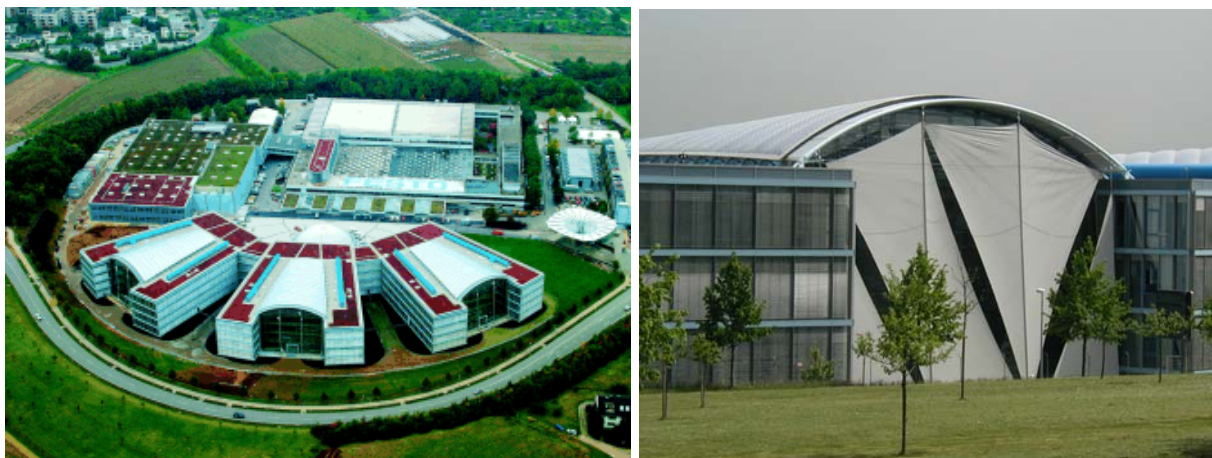
Abbildung 3: Bürogebäude der Fa. FESTO AG & Co. KG in Esslingen
