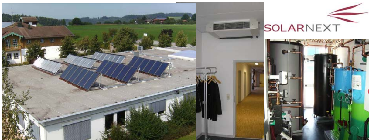
Abbildung 1: Bürogebäude und Cillii® Solar Cooling System der SolarNext AG, Rimsting
