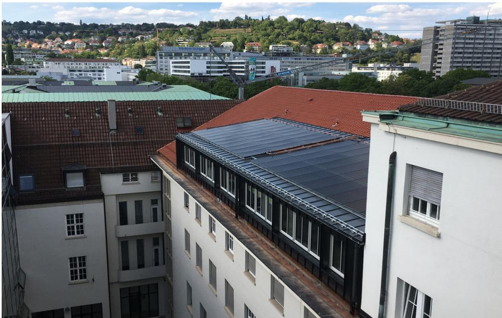
Abbildung 8: Photovoltaik-Thermie-Anlage auf dem Dach von Bau 2<sup>9</sup>
