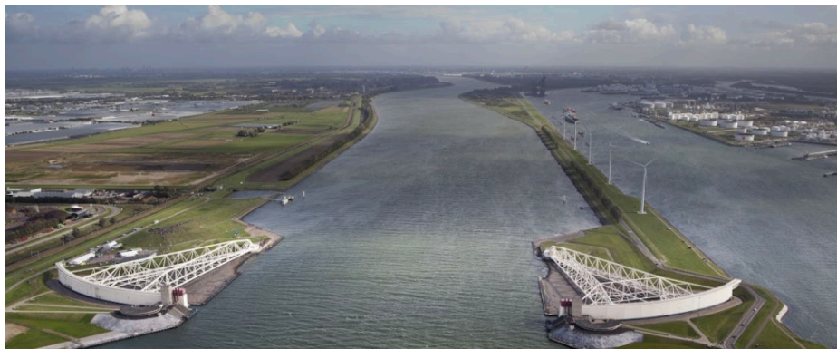
Bild 2 Maeslantkering mit den beweglichen Toren
