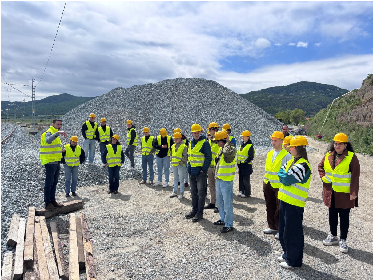
Baustellenbesichtigung im Abschnitt Ichtiman der Bahnstrecke Sofia–Plowdiw
