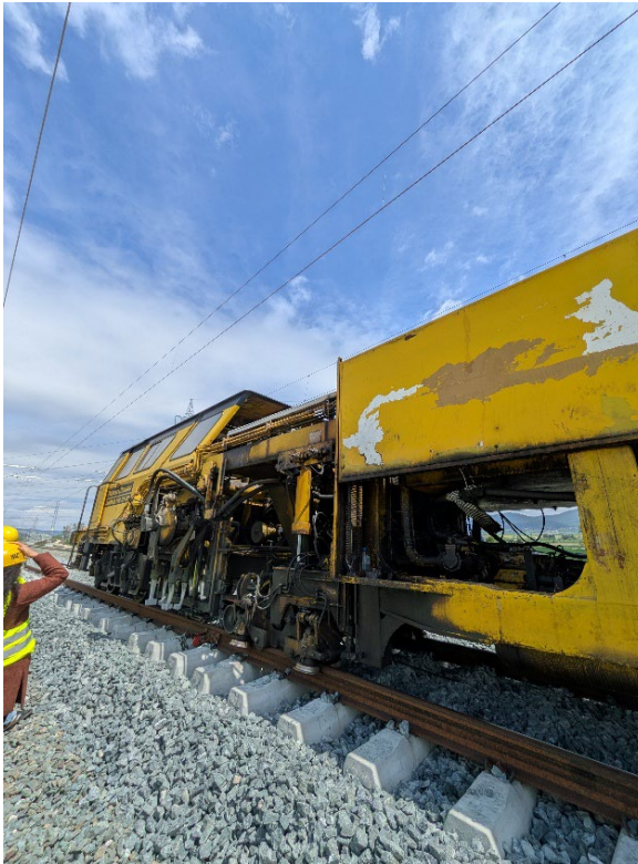
Gleisbaumaschine im Baustelleneinsatz
