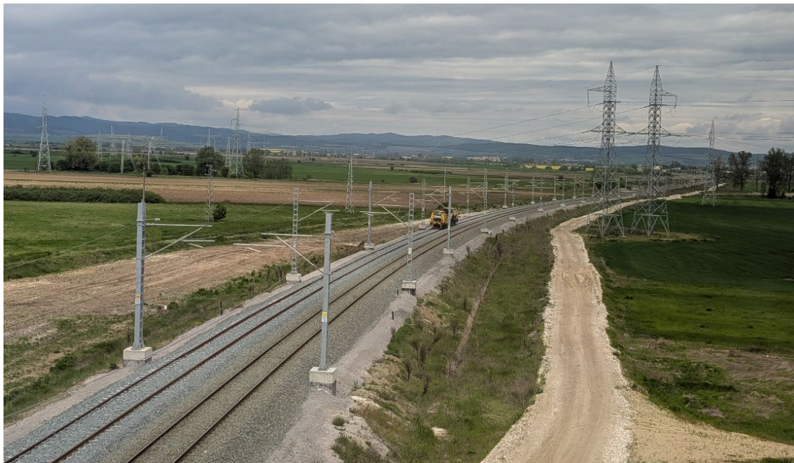
Überblick über den zweigleisig ausgebauten Abschnitt
