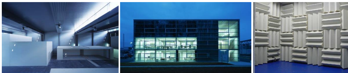
Bauphysik-Laborgebäude in Stuttgart-Vaihingen (Bilder: Körner)
