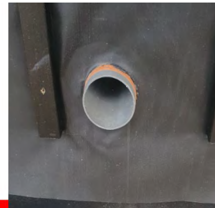
Konstruktion Decke / Außenwand mit Zuluftöffnungen (veränderte Optik im Laufe der Bauzeit)
