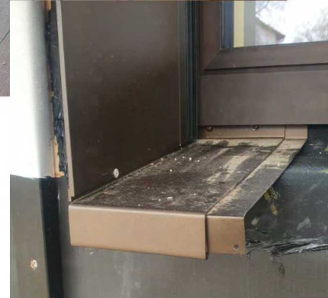
Fenster: temporäre Abdichtung Bauzeit, 2. Abdichtungsbene unter Sims
