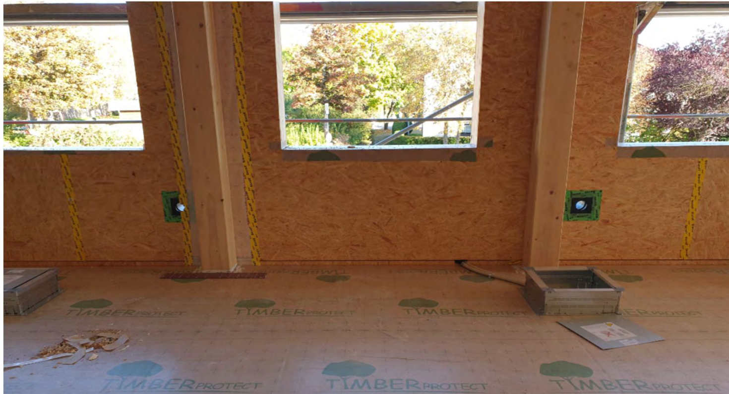
Konstruktion Decke / Außenwand mit Zuluftöffnungen (veränderte Optik im Laufe der Bauzeit)
