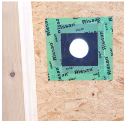
Konstruktion Decke / Außenwand mit Zuluftöffnungen (veränderte Optik im Laufe der Bauzeit)
