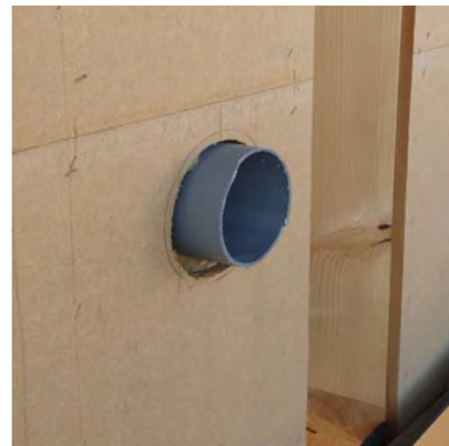
Konstruktion Decke / Außenwand mit Zuluftöffnungen (veränderte Optik im Laufe der Bauzeit)
