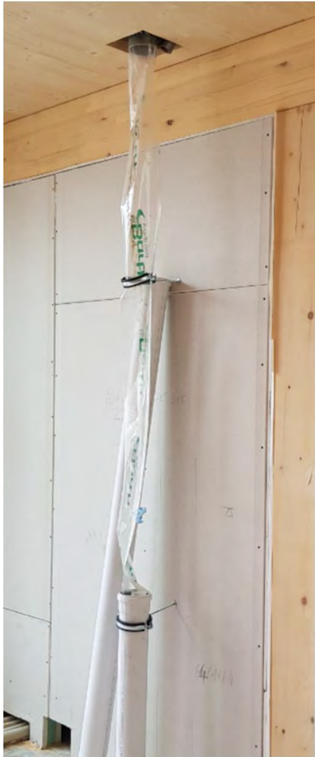
Schutz gegen Wasser – temporär während Bauzeit und nach Fertigstellung , Schmutz- und Regenwasser
