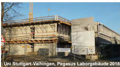
Uni Stuttgart-Vaihingen, Pegasus Laborgebäude 2018
