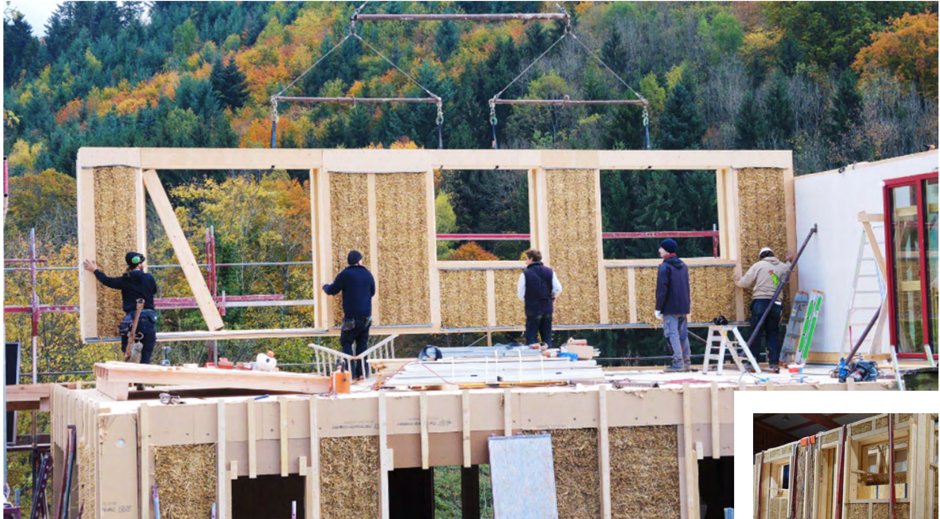
Holz- Stroh-Lehmbauweise – Aufrichten eines vorgefertigten Gebäudes Zimmerei Grünspecht, Freiburg
