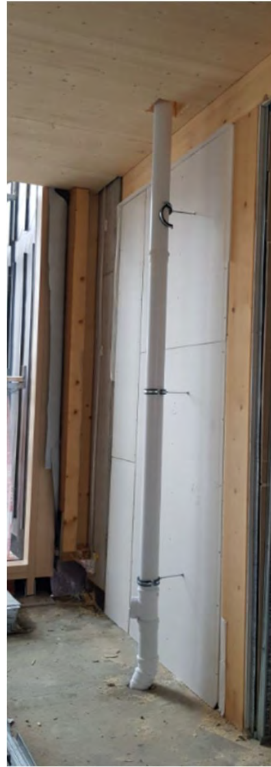
Schutz gegen Wasser – temporär während Bauzeit und nach Fertigstellung , Schmutz- und Regenwasser
