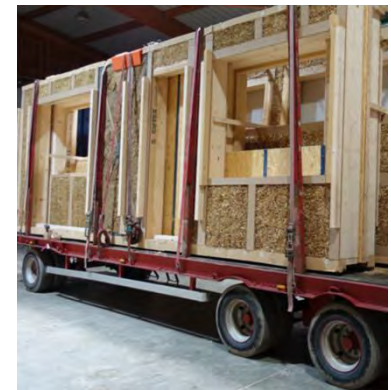
Holz- Stroh-Lehmbauweise – Aufrichten eines vorgefertigten Gebäudes Zimmerei Grünspecht, Freiburg
