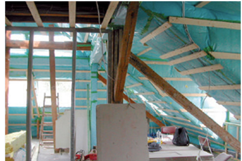
Die luftdichte Ebene ist noch sichtbar und zugänglich (Folie und Holzbauplatte): Der optimale Zeitpunkt für eine BlowerDoor Messung.
