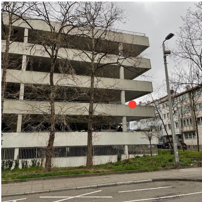
Abbildung 5: Fassade des Parkhauses mit Position des Lärmsensors (roter Punkt).
