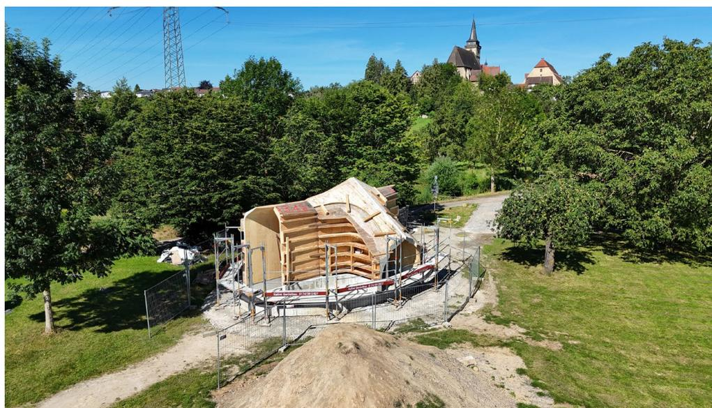
Abbildung 37: Re-Use-Baukomponenten von Betonschalungen für neue Bauaufgaben.
