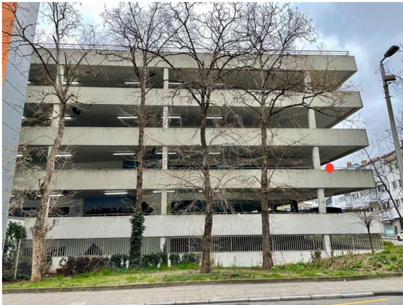
Abbildung 20: Fassade des Parkhauses mit Position des Lärmsensors (roter Punkt) (Eigene Aufnahme)
