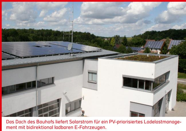
Das Dach des Bauhofs liefert Solarstrom für ein PV-priorisiertes Ladelastmanagement mit bidirektional ladbaren E-Fahrzeugen.
